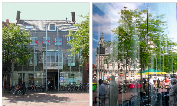
Afbeelding 10 en 11 > Voorzetgevel van enkel glas voor een boekhandel in Middelburg: recht van voren en onder scherpe hoek.
